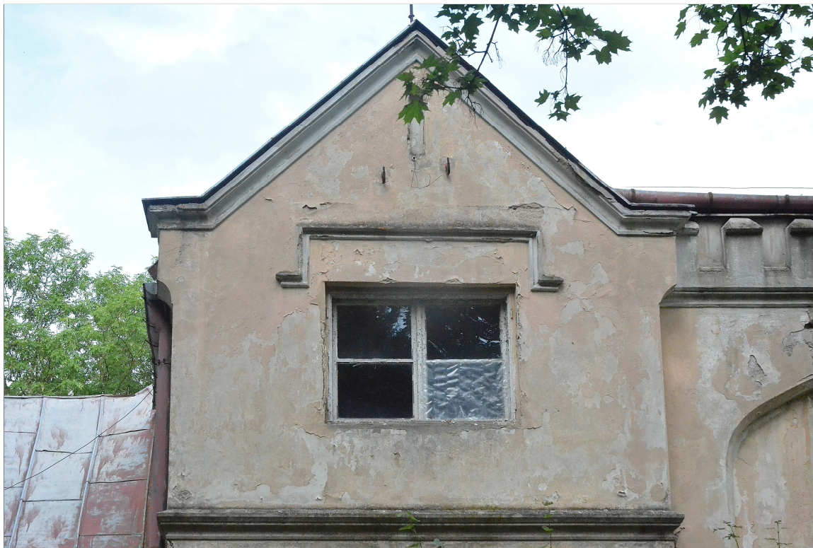
II. 17 Wieniec, tzw. Stary dwór – elewacja zachodnia - widok na wtórną stolarkę okienną w szczycie pseudoryzalitu
