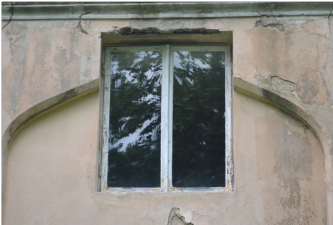
II. 15 Wieniec, tzw. Stary dwór – elewacja południowa - widok na wtórne otwory okienne i stolarkę okienną
