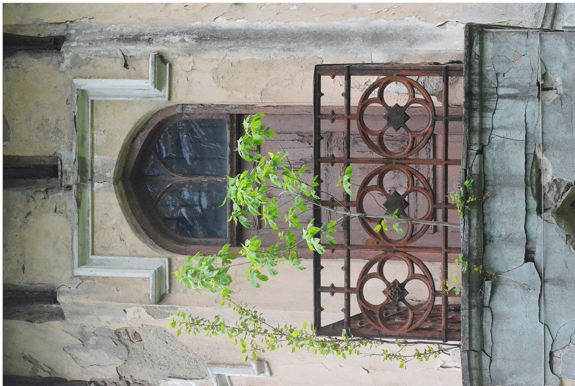
II. 11 Wieniec, tzw. Stary dwór – elewacja wschodnia wieży - drzwi balkonowe w II kondygnacji w wieży z zachowanym pierwotnym nadświetlem - awers
