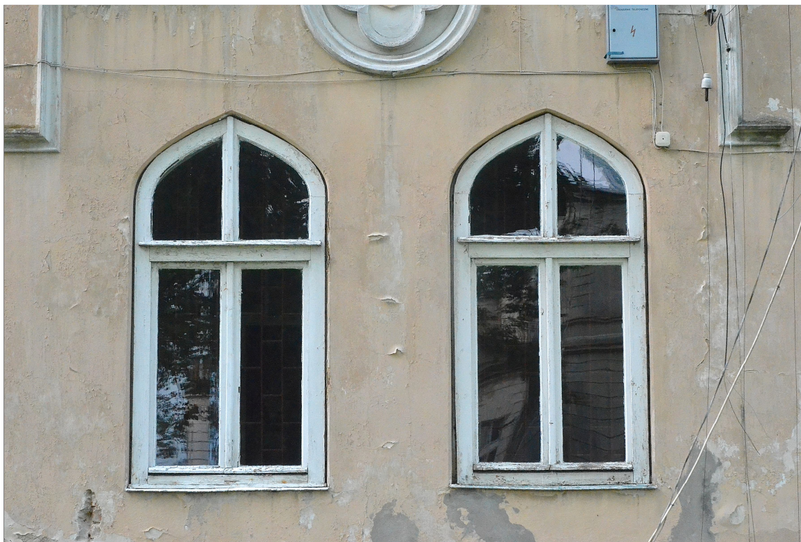
II. 14 Wieniec, tzw. Stary dwór – elewacja południowa - widok na wtórną stolarkę okienną - awers
